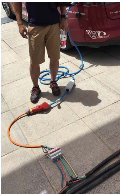
Sicherheit muss sein: ein Leitungsschutzschalter an einem eher ungewöhnlichen Stromanschluss.
